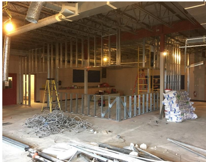
Rm.120 Metal Stud Framing 7-11-18
